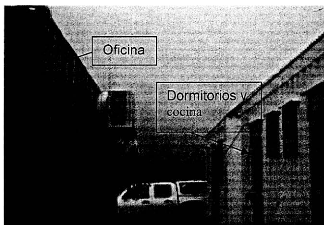
Foto 5: Circulación exterior sin cubierta
